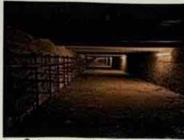
Im Schacht über einer U-Bahn
